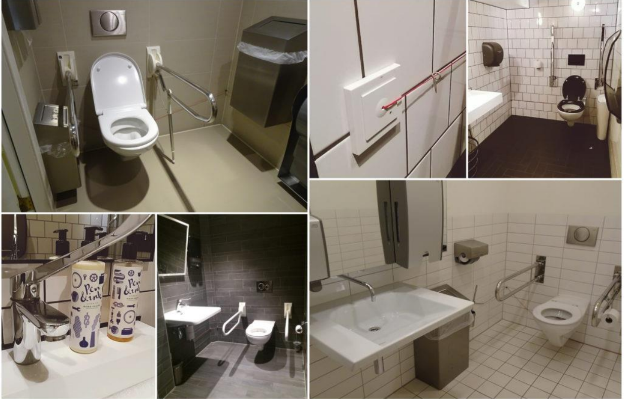
चित्र 13: सुगम्य प्रसाधन टाइप ए में लीवर टाइप नल, मुड़ने योग्य ग्रैब बार आदि का उदाहरण (स्रोत: https://www.ableamsterdam.com/wp-content/uploads/2019/06/accessible-toilets-2-1024x662.jpg )
