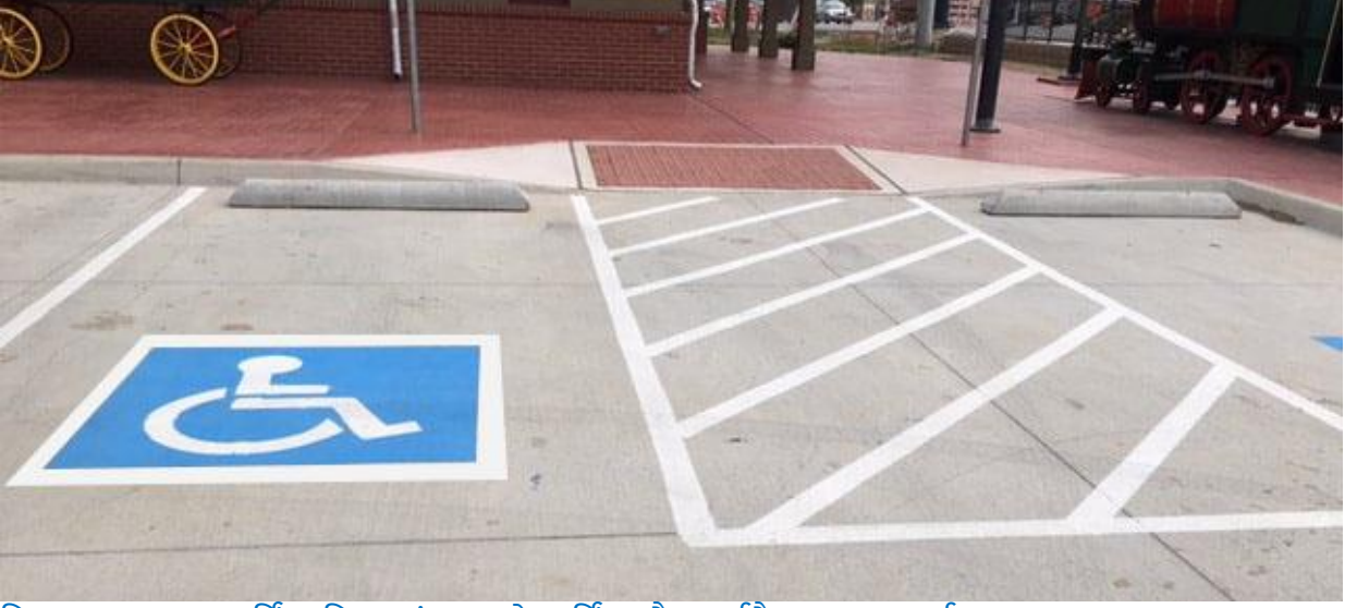
चित्र 1: सतह पर पार्किंग चिह्न, ट्रंसफर बे मार्किंग और कर्ब रैम्प का आदर्श रूप
